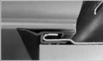
Wirkungsvolle Torabdichtung zum Baukörper
