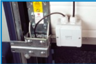
Seilbruchsicherung
